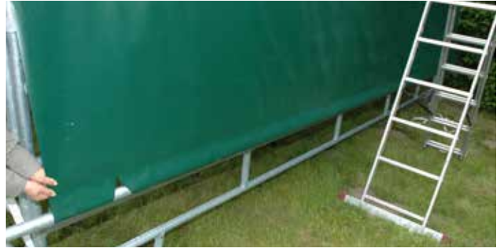
Schritt 29: Einführen des Abspannrohrs in die dafür vorgesehene Abspanntasche.
