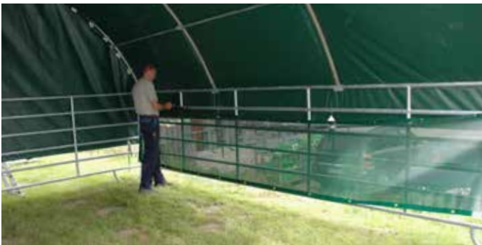
Schritt 32: Jede Öse mittels Kabelbinder am Panel befestigen und überstehende Enden der Kabelbinder einkürzen.
