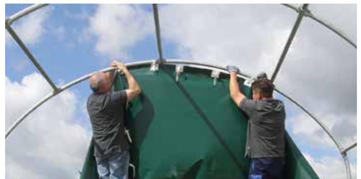
Schritt 27: Befestigung der Schnallen am Bogen mit der mittleren Schnalle der Giebels im First (links oder rechts vom obersten Druckrohr) beginnen und nach außen arbeiten.
