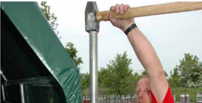
Schritt 18: Eintreiben der Bodenbefestigungsrohre mittels Hammer (Oberkante Bodenbefestigung = Oberkante der dritten Querstrebe von oben).
