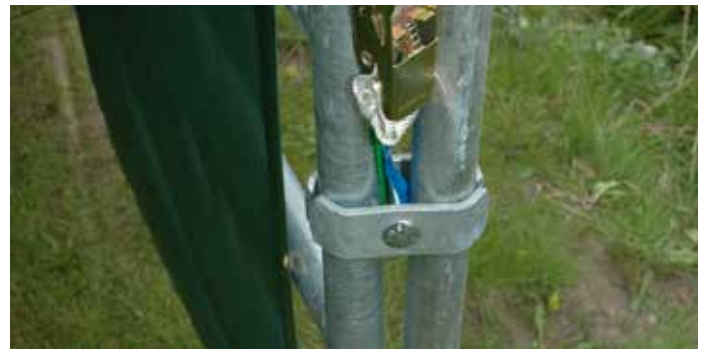
Schritt 19: Befestigung der Panels am Bodenbefestigungsrohr mittels Zaunklammer.
