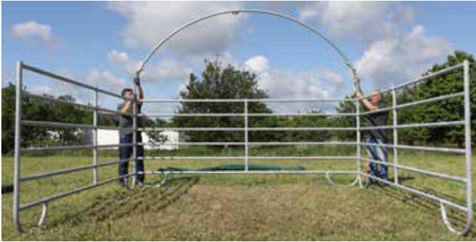
Schritt 11: Anschließend alle Bögen aufstellen.
