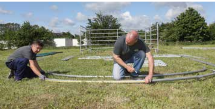
Schritt 7: Ausmessen der Schellenposition. Macht sich am Boden besser als am montierten Bogenelement.
