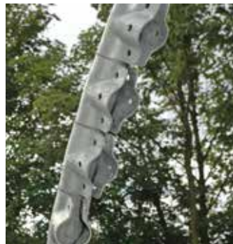
Schritt 9: Zunächst die Hälfte der mitgelieferten T-Schellen auf den ersten, die andere Hälfte auf den letzten Bogen aufschieben.
