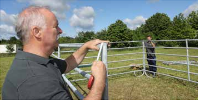
Schritt 5: Ausrichtung der Panels, Quer- und Seitenpanel im rechten Winkel und Seitenpanels zueinander parallel.
