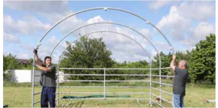
Schritt 12: Die Bögen mit den T-Schellen an den Außenseiten, den Bogen ohne Schellen in die Mitte des Mobil Covers stellen.
