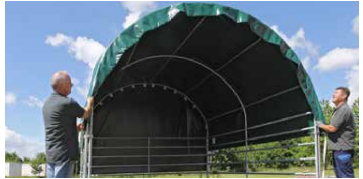
Schritt 23: Die Dachfolie in Längs- und Querrichtung symmetrisch ausrichten.
