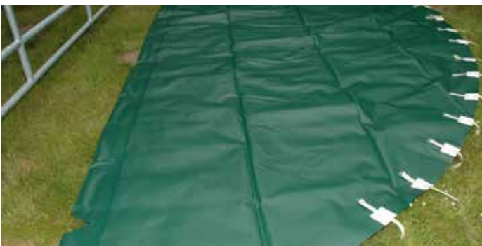
Schritt 26: Falls ein Giebel vorhanden ist, diesen mit den Schnallen nach innen ausbreiten.
