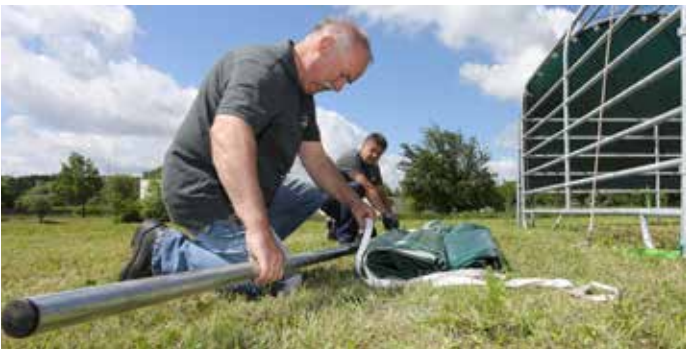
Schritt 20: Ausbreiten der Dachfolie an Längsseite und Einführen der Abspannrohre.
