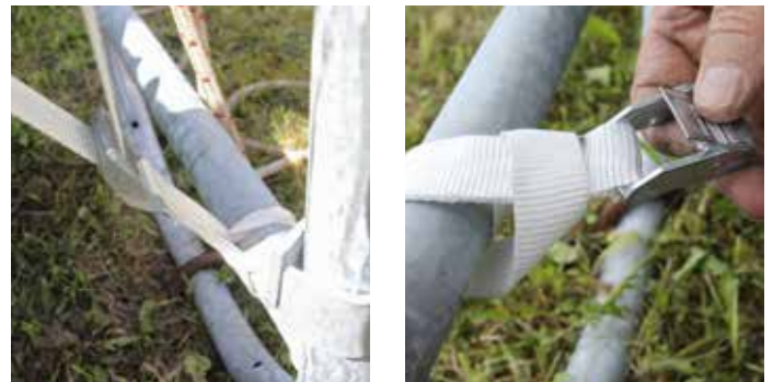
Schritt 25: Den Flap (weißes Gurtband) ebenfalls beidseits mittels Abspanngurte auf Spannung bringen.
