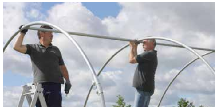
Schritt 15: Am mittleren Bogen kommen die Kreuz-Schellen zum Einsatz. Diese auch mittig am Bogen anschlagen und das Druckrohr bis zum Anschlag in die Schelle schieben. Um eine perfekte Form der Folie zu garantieren, darf der Abstand der unteren Druckrohre zum Panel nicht zu großzügig gewählt werden (ca. 45 cm Abstand zum Panel).
