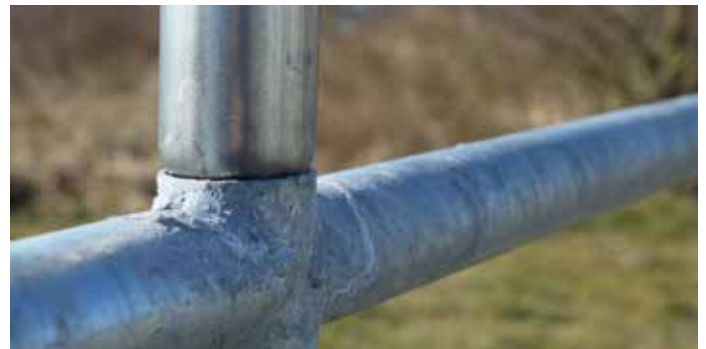
Schritt 10: Den Bogen bis zum Anschlag über den Fußpunkt schieben.
