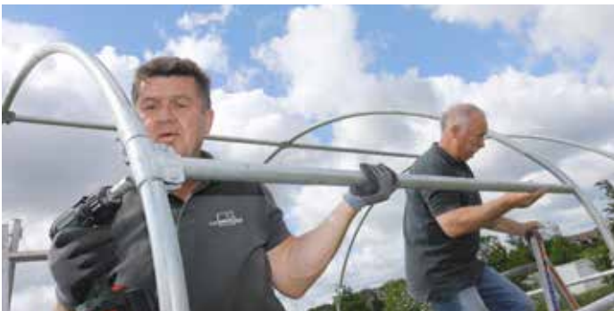
Schritt 13: Nun werden die Druckrohre installiert.
