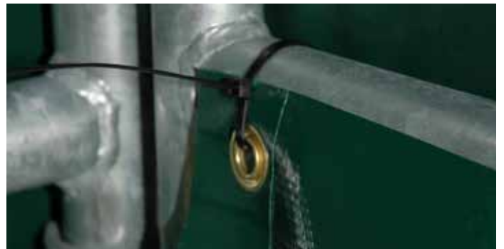
Schritt 31: Windschutznetze mittels Kabelbinder innen am Panel befestigen.
