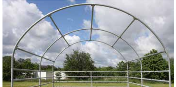
Schritt 17: Die mitgelieferten Druckrohre müssen gleichmäßig verteilt werden.
