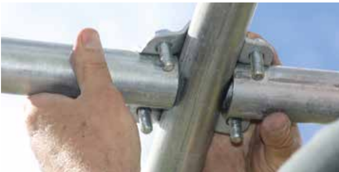
Schritt 15: Am mittleren Bogen kommen die Kreuz-Schellen zum Einsatz. Diese auch mittig am Bogen anschlagen und das Druckrohr bis zum Anschlag in die Schelle schieben. Um eine perfekte Form der Folie zu garantieren, darf der Abstand der unteren Druckrohre zum Panel nicht zu großzügig gewählt werden (ca. 45 cm Abstand zum Panel).
