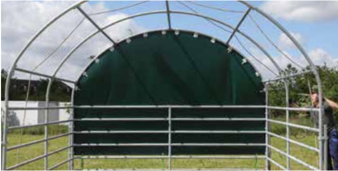
Schritt 28: Giebelwand vor Abspannung.
