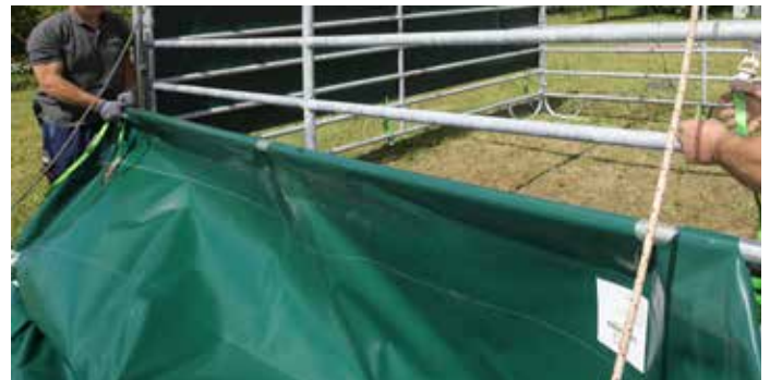
Schritt 21: Befestigung eines Seils am Abspannrohr, welches über die Dachkonstruktion zur gegenüberliegenden Seite geworfen wird.
